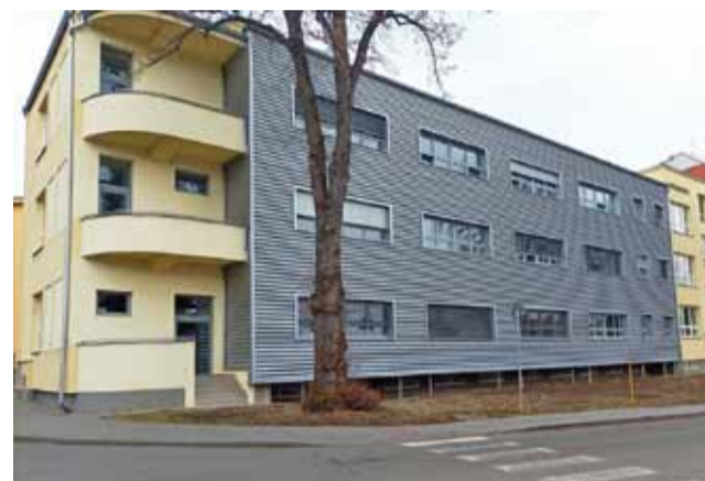
Rekonstrukce pavilonu chirurgie Slezské nemocnice byla dokončena.
